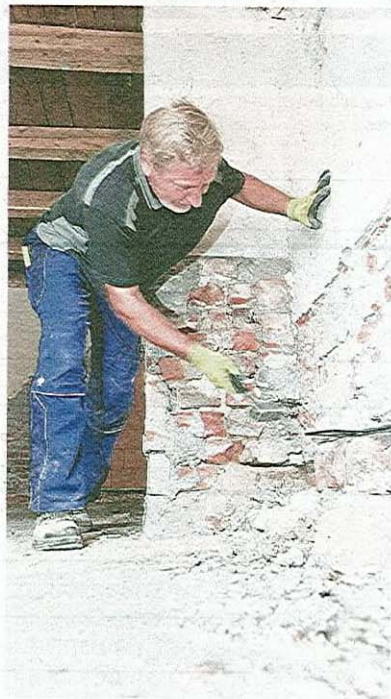
Udo Schwarz von einer Spezialfirma arbeitet an der Horizontalsperre, die das Gebäude vor aufsteigender Nässe schützen soll.
