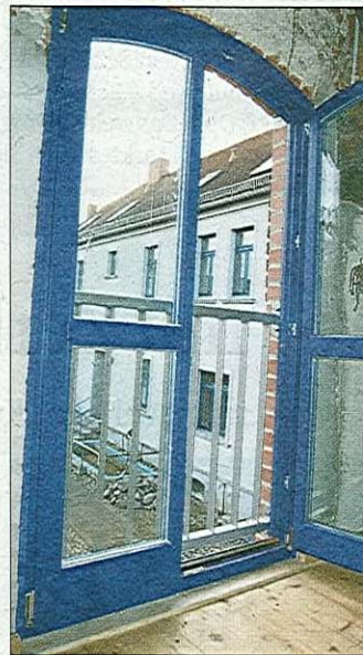
Im Dachgeschoss des einstigen Stallgebäudes wurden neue Glaselemente eingesetzt.
